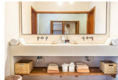
Barra doble de lavabos
